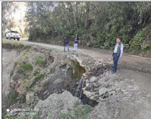
Figura 01. Se muestra un grave proceso de socavación que ha afectado directamente la vía rural, dejando una sección colapsada y poniendo en riesgo la continuidad del camino y la seguridad de los transeúntes. El flujo constante de agua por debajo de la calzada ha debilitado la estructura, por lo que se requiere una intervención inmediata con obras de drenaje y
